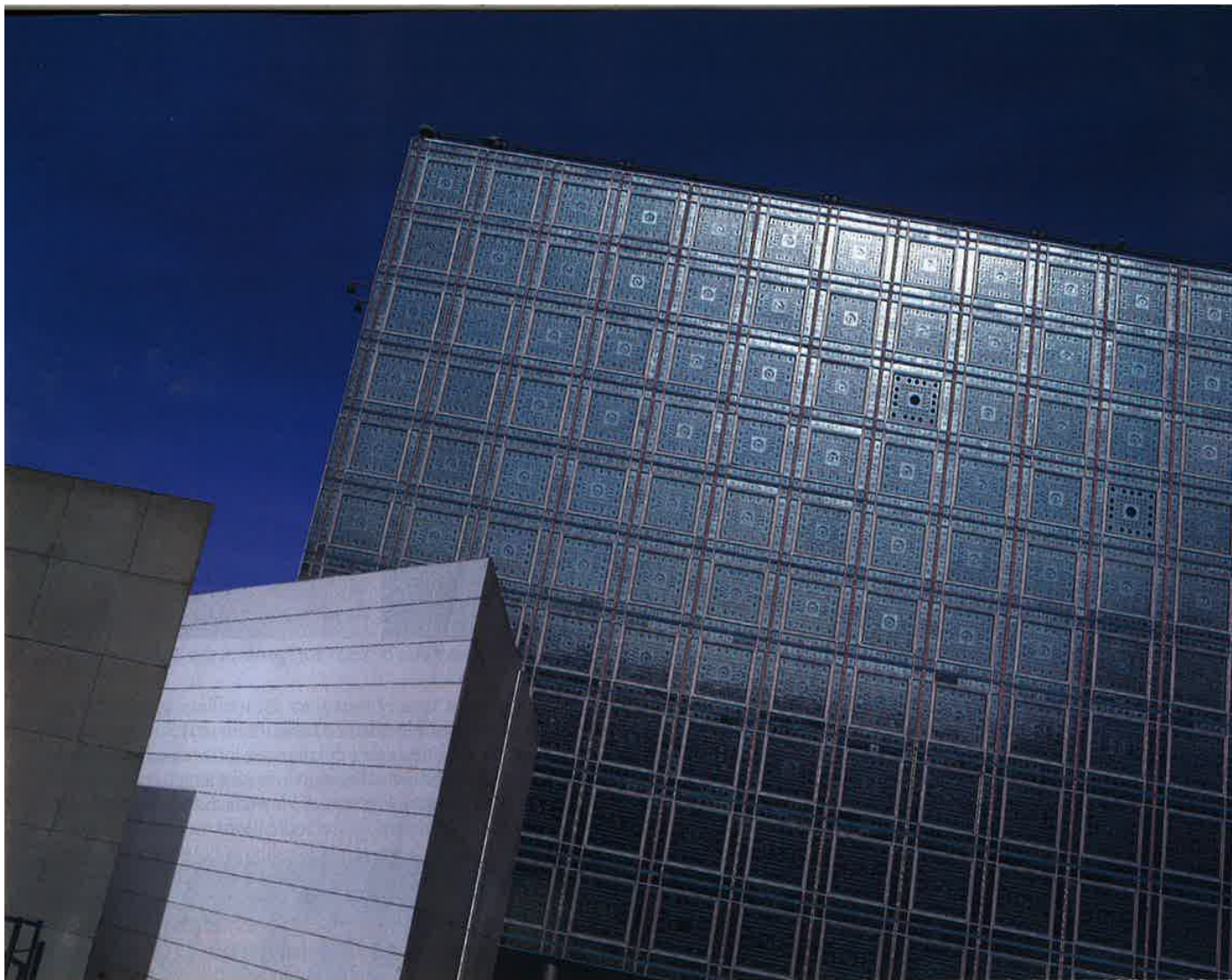
Le bâtiment dessiné par Jean Nouvel vient de rénover ses moucharabihs pour 3 millions d'euros.
